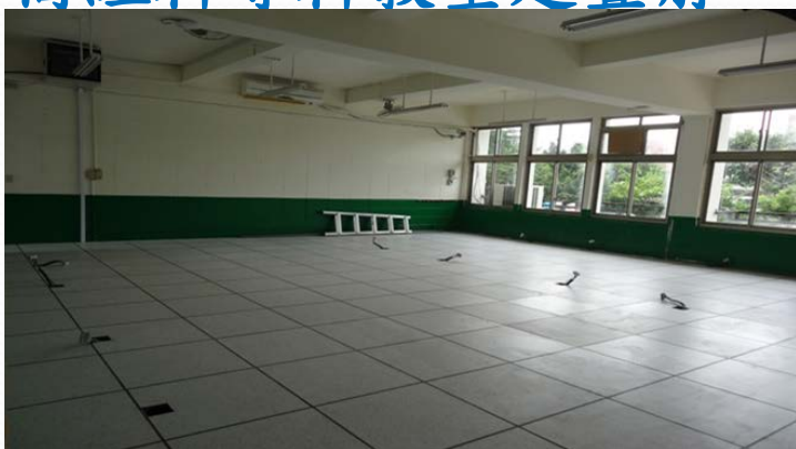
高架地板與線路完成
